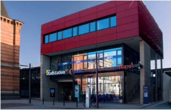
Radstation am Hauptbahnhof Bremen
