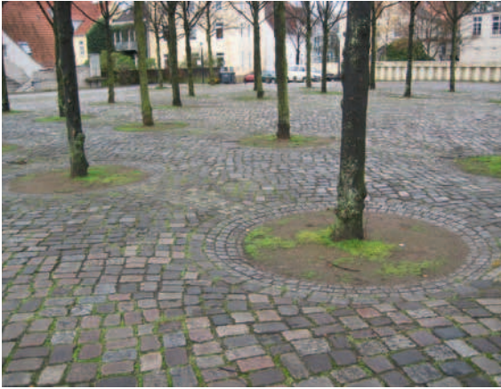
Keine Orientie- rungshilfen für Blinde und Sehbehinderte: Platzgestaltung in Vegesack
