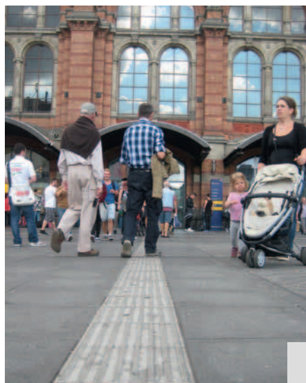
Blindenleitstreifen vor dem Hauptbahnhof
