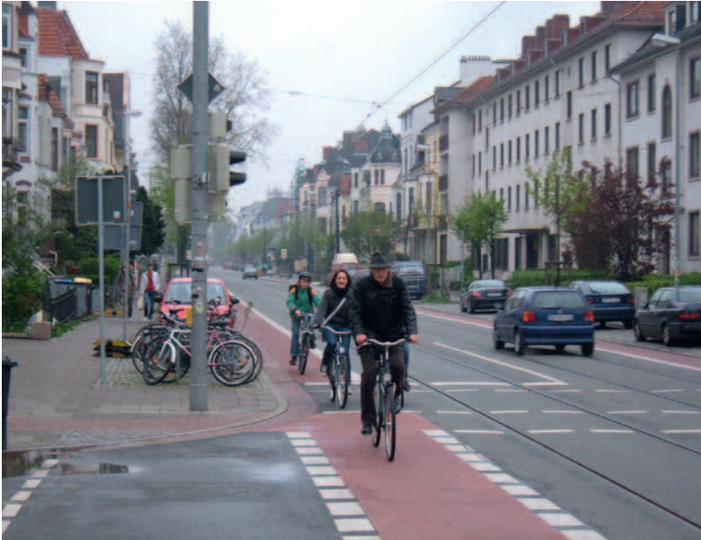
Umbau für alle Verkehrsarten trotz beengtem Querschnitt – Hamburger Straße
