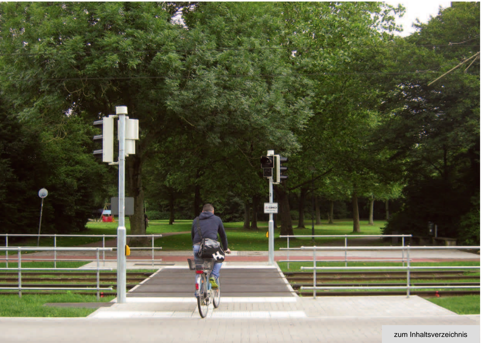
Bgm.-Hildebrand-Straße: Komfortable und sichere Querung der Straßenbahngleise statt Drängelgitter
