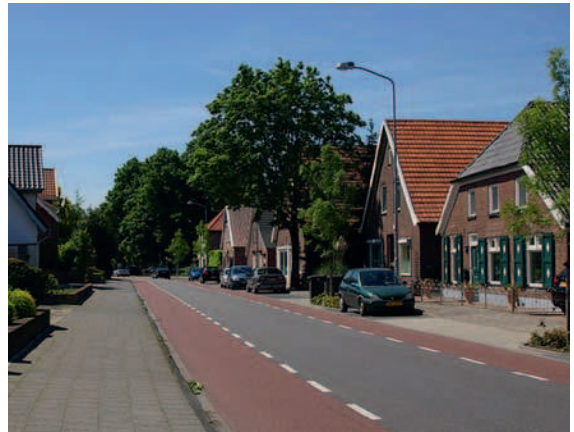
Führung des Radverkehrs auf Schutzstreifen in der Fahrbahn – Heinrich-Oebker-Straße
