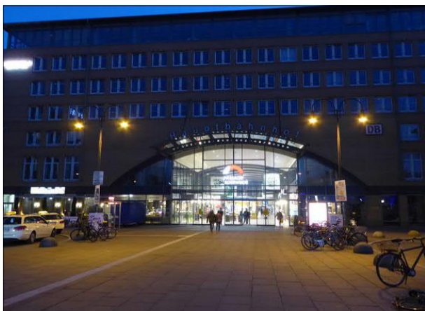
Abbildung 24: Am Eingang von der Bürgerweide waren in Bremen sowohl das DB-Logo als auch der Schriftzug „Hauptbahnhof“ unbeleuchtet.
