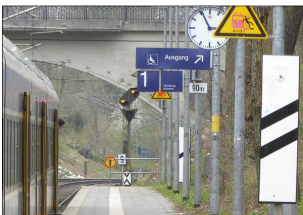
Abbildung 51: Um auch bei kürzeren Zügen fahrgastfreundliche, zugangnahe Zughaltepositionen zu gewährleisten, wurden an einzelnen Stationen neue Schilder installiert. Zu sehen ist in Bremen-Lesum ein Schild „90m“.
