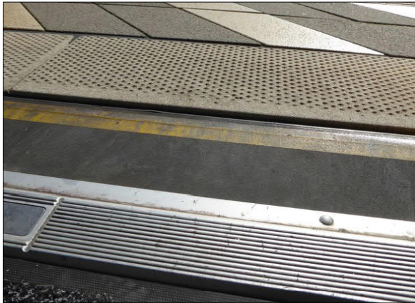
Abbildung 4: In Bremen-Mahndorf ist nur ein geringer Höhenunterschied zwischen der Bahnsteigoberfläche und der Trittstufe des Eingangs in die Regio-S-Bahn festzustellen.
