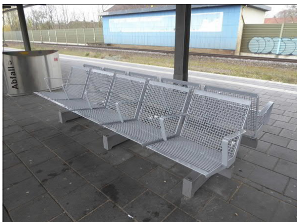
Abbildung 3: Die 2018 noch stark angerosteten Sitzgelegenheiten auf den Bahnsteigen des Hauptbahnhofs in Bremerhaven wurden alle aufgearbeitet und neu beschichtet.
