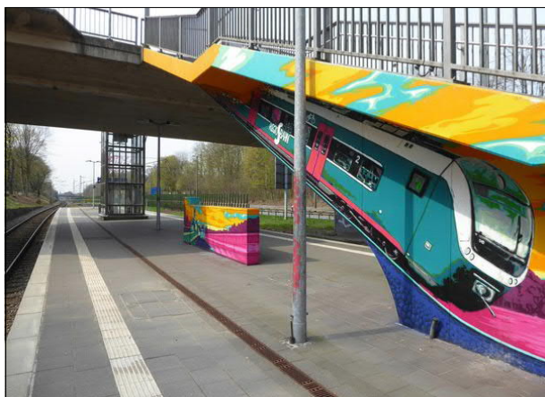
Abbildung 2: Die Gestaltung des Schallkastens und der Betonflächen an der Bahnsteigtreppe von Bremen-St. Magnus wirkt sich auch ein Jahr nach Fertigstellung positiv auf das Erscheinungsbild aus.
