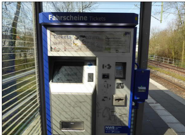
Abbildung 31: Das Infopanel oberhalb des Bildschirms war im Fahrkartenselbstbedienungsautomat von Bremen-Blumenthal durch Schäden und Verschmutzungen unansehnlich.
