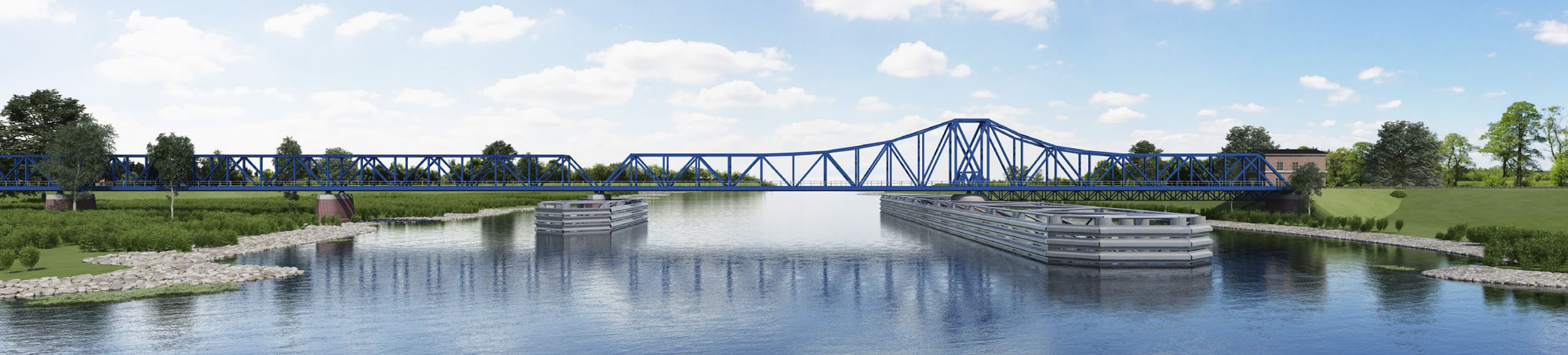
Eine erste Impression der neuen Friesenbrücke 9
