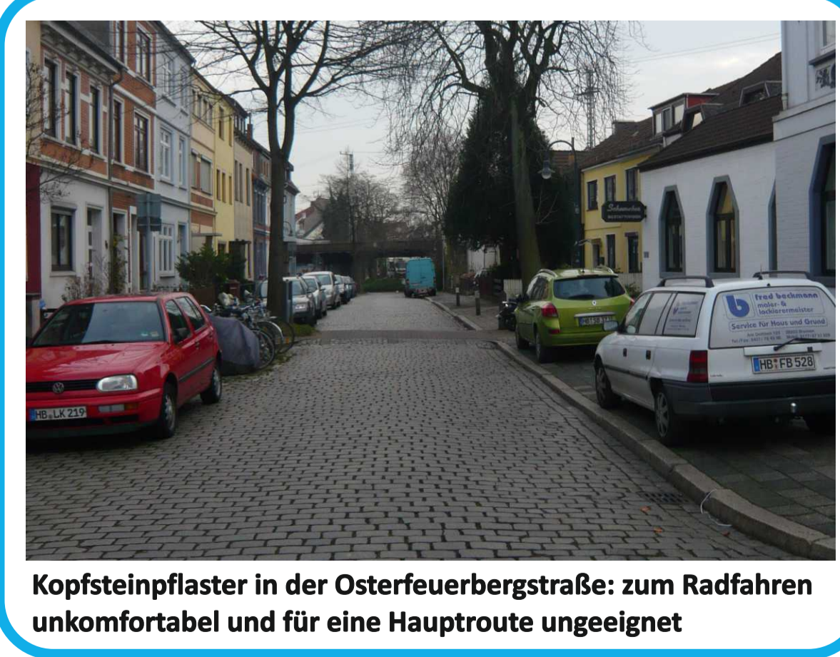
Kopfsteinpflaster in der Osterfeuerbergstraße: zum Radfahren unkomfortabel und für eine Hauptroute ungeeignet
