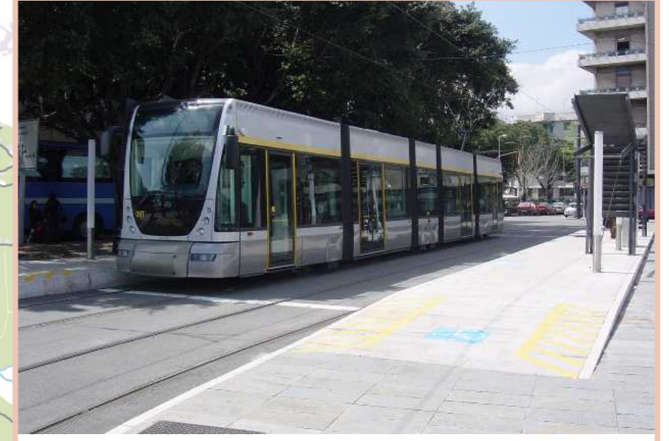
Barrierefreier Zugang zur Haltestelle
