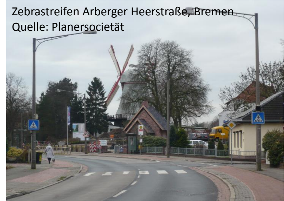
Attraktiv gestaltete Mittelinsel, aber nicht barrierefrei Quelle: Planersocietät
