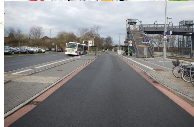
Bahnhof Mahndorf (Südseite)
