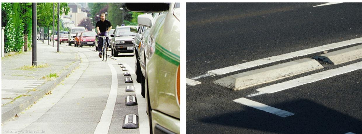
Bild 8: Beispiele für Reflektorschwellen zur Verhinderung der Befahrbarkeit von Teilen der Fahrbahn
