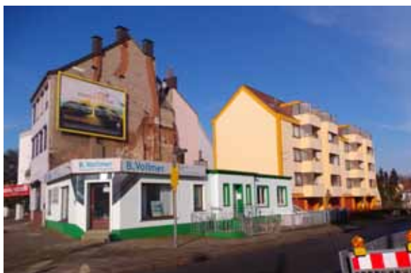
Viele Einmündungen der Heerstraße sind durch städtebauliche Missstände geprägt
