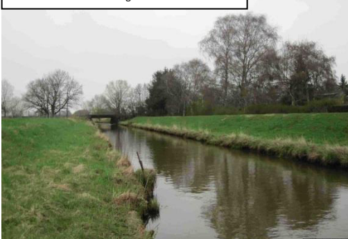
Klosterbach Unterlauf-eigedeichtes Gewässer
