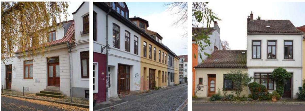
**Abbildung 2-6 Frühe eingeschossige Bremer Häuser in der Rutenstraße, Heinrichstraße und Albrechtstraße. Die Häuser wurden später entweder aufgestockt oder die Dachräume wurden ausgebaut**
