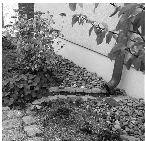
Regenwasser: oberflächliche Führung und Retention
