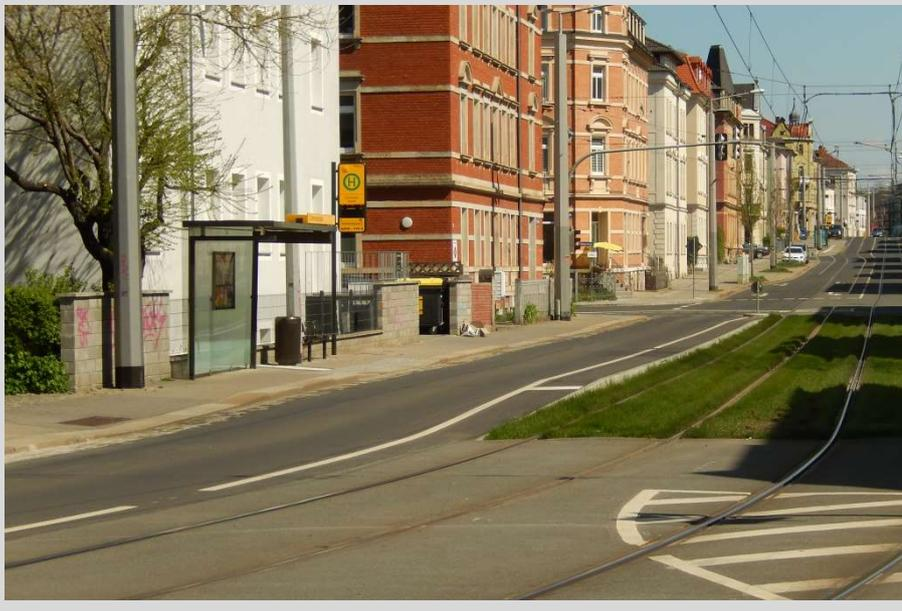
Abbildung 8.6: Beispiel Haltestelle mit angehobener Fahrbahn – Pennricher Str. Dresden
