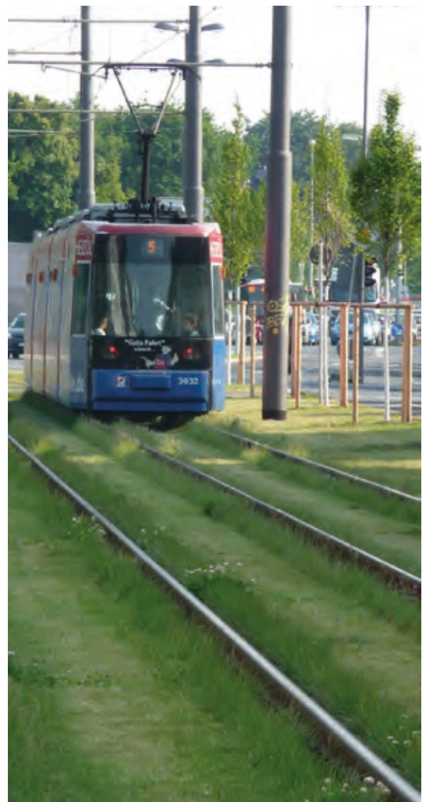
Abb. 36. Rasengleis (Claus Gieseler)
