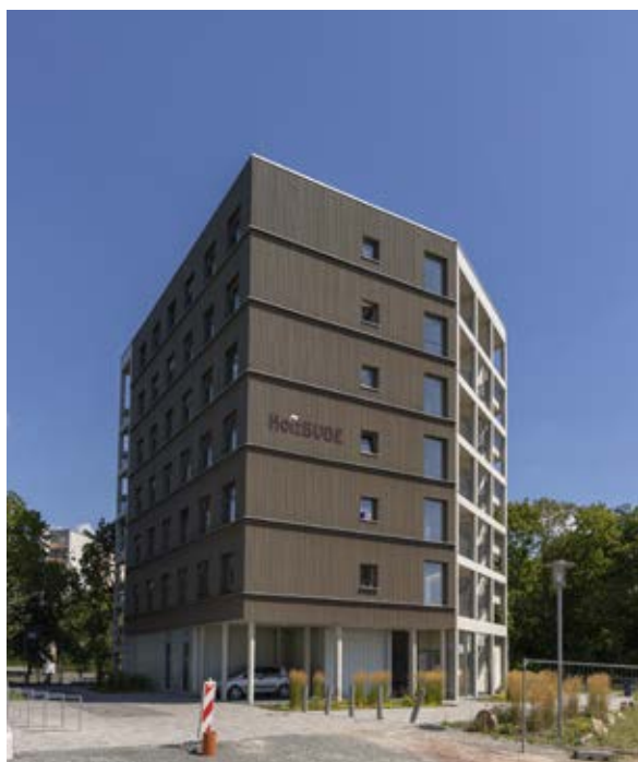
Das Studierendenwohnhaus „Holzbude“ im Ellener Hof ist aktuell das höchste Holzgebäude in Bremen. Foto: Rainer Geue, Bremer Heimstiftung
