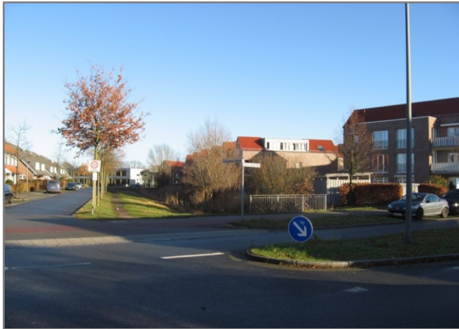
Zweiter Bauabschnitt „Seniorenstift“; im Hintergrund die Grundschule
