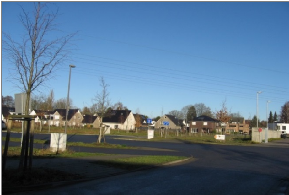
Hamfhofsweg nach Fertigstellung...
