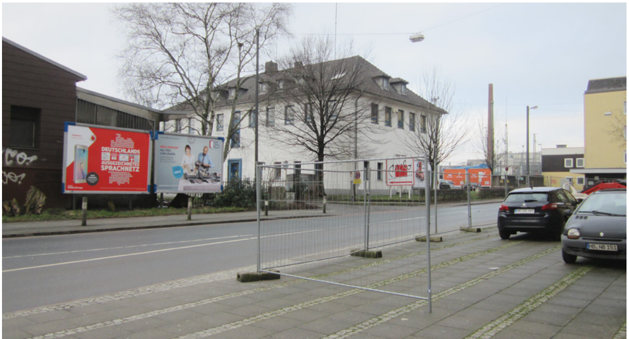
Abb. 10 - Bestandsfoto: DB-Gebäude - Bürgermeister-Smidt-Straße
