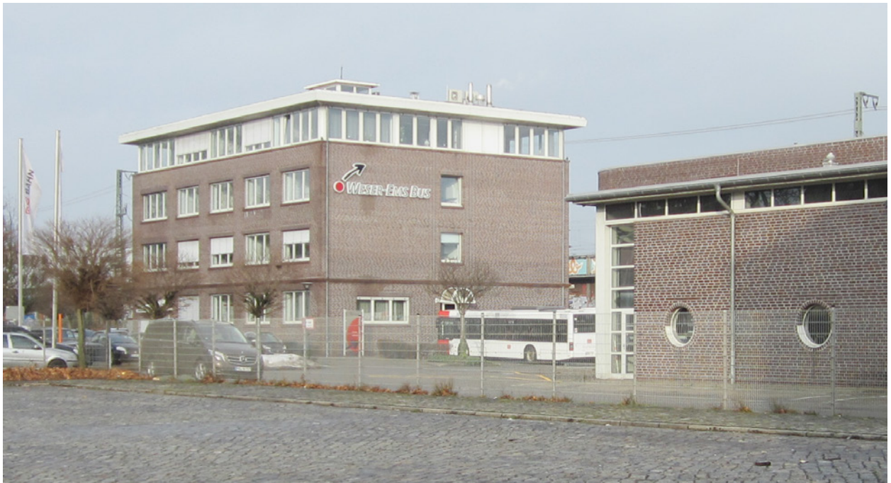
Abb. 1 - Bestandsfoto: WEB-Bürogebäude - Beitenweg
