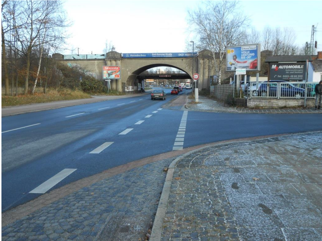
Abbildung 5: zwei der Eisenbahnbrücken in der Steubenstraße
