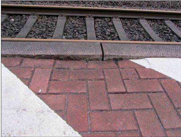
**Abbildung 4:** Der Bahnsteig an Gleis 3 in Bremen-Oberneuland wies größere Absackungen mit Stufenbildung an den Bahnsteigkanten auf.
