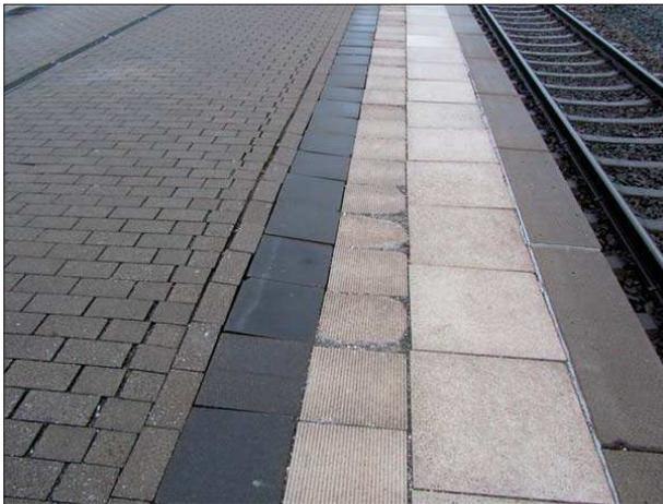
**Abbildung 5:** Die Schäden und Unebenheiten am Mittelbahnsteig von Bremen-Burg sind deutlich zu erkennen.
