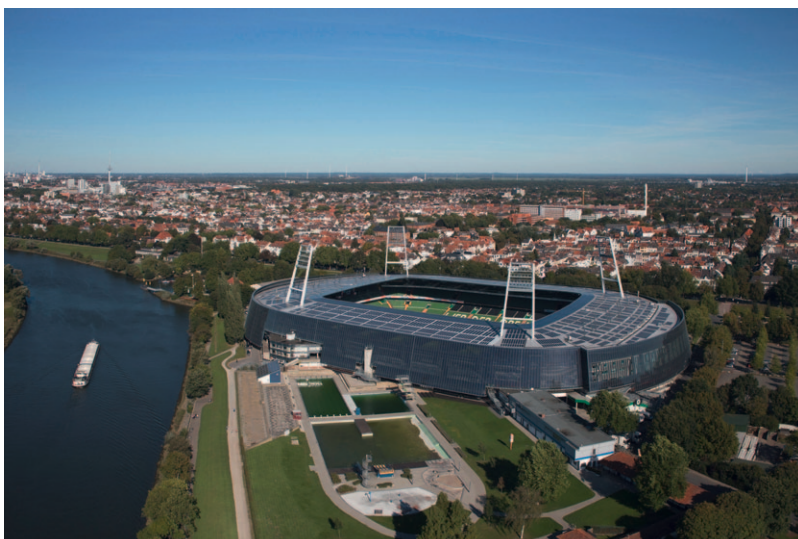
Die Photovoltaikanlage am Weserstadion hat eine Gesamtleistung von rund 1,2 Megawatt peak
