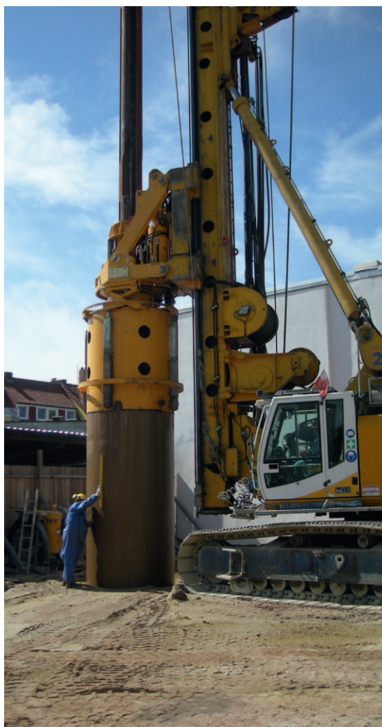
Das Großbohrgerät im Einsatz
