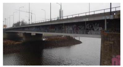
Das Bauwerk unterliegt mittlerweile einer deutlichen höheren Verkehrsbelastung als es zum Zeitpunkt der Erstellung berechnet wurde. Im Zuge einer statischen Prüfung auf Grundlage der Nachrechnungsrichtlinie zeigte sich, dass das Bauwerk statische und ermüdungskritische Defizite aufweist. Die im Bauwerk vorgefunden Risse können anhand der Nachrechnung nachvollzogen werden. Die statischen Nachrechnungen des Bauwerkes sind noch nicht abgeschlossen.
