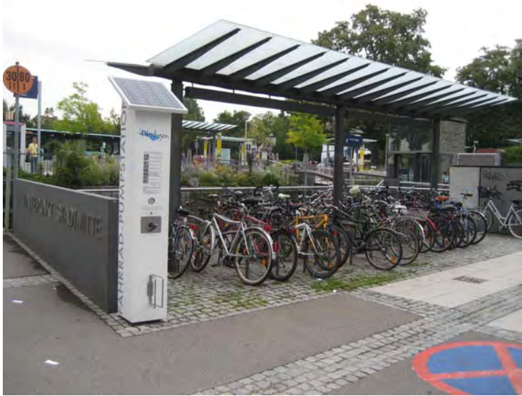
Abbildung 2-18 Stationäre Luftpumpstation an B+R-Anlage in Überlingen Bodensee
