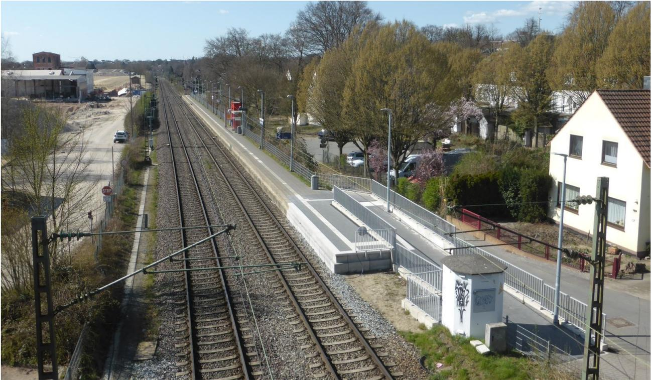
**Abb. 4:** Auf 180 Meter verlängerter Außenbahnsteig mit neuer Zugangsrampe in Bremen-Schönebeck (Fahrtrichtung Bremen-Vegesack)
