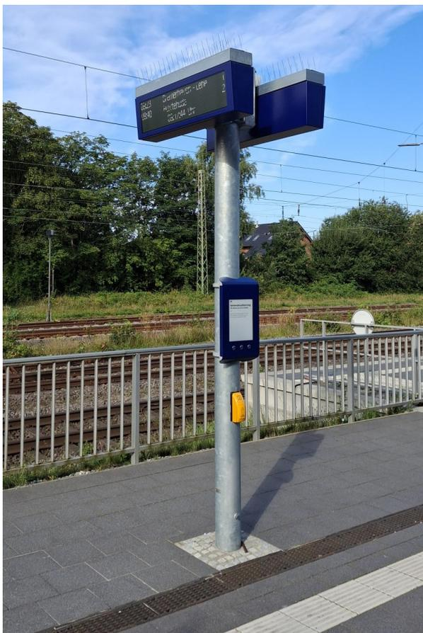
**Abb. 8:** Der neue Dynamische Schriftanzeiger (DSA+ Premium) in Bremerhaven-Wulsdorf einschließlich elektronischem Aushang der Baufahrpläne
