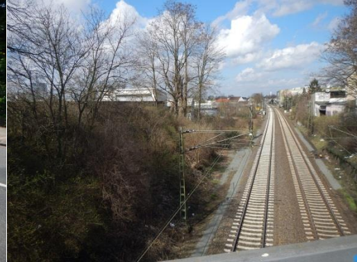
Bild 5-39 Blick von der Brücke Hannoversche Straße über die Osnabrücker Bahn: links am Bildrand könnte eine Rampe zur ehemaligen Bahn- trasse Richtung Kraftwerk- deich verlaufen
