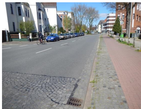
Bild 7-29 Steffensweg: Zweirichtungsradweg mit Übergang Pflaster in bituminöse Fahrbahn
