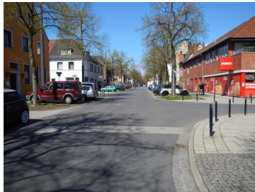
Bild 5-23 Vegesacker Straße, aufgefasterter Kreuzungsbereich in Tempo-30-Zone
