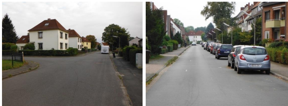
Bild 7-1 Beispiel Aumunder Heide: Abschnittsweise einseitig Parkstände mit Unterbrechungen markieren (Ersatzparkraum ggf. auf ehemaligem Sportplatz möglich).
