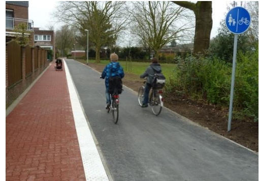
Bild 4-29 Getrennter Rad- und Gehweg mit taktilem Begrenzungsstreifen (Bocholt, Foto W. Angenendt)
