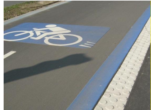
Bild 4-41 Taktile Trennung zum Gehweg (eRadschnellweg Göttingen).
