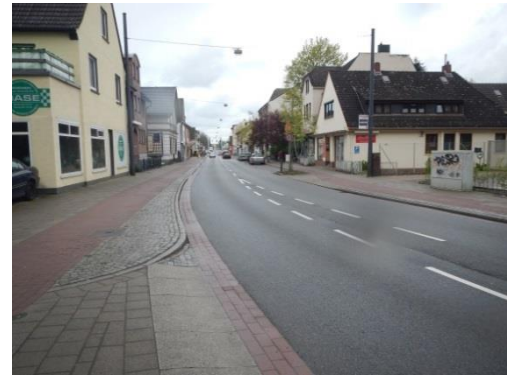
Bild 7-5 Geringes Verbreiterungspotenzial für die Radwege in der Burger Heerstraße auf kurzem Teilstück
