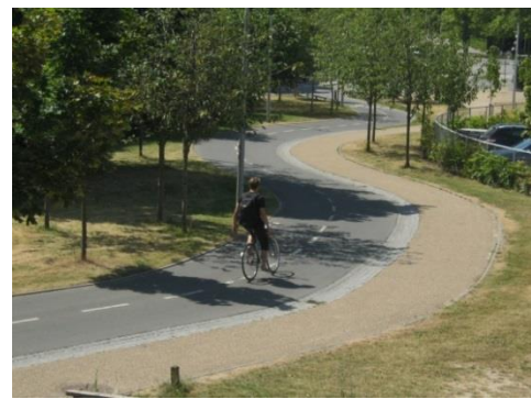
Bild 4-31 Mittlere Leitlinie bei kurviger Linienführung (Kopenhagen)
