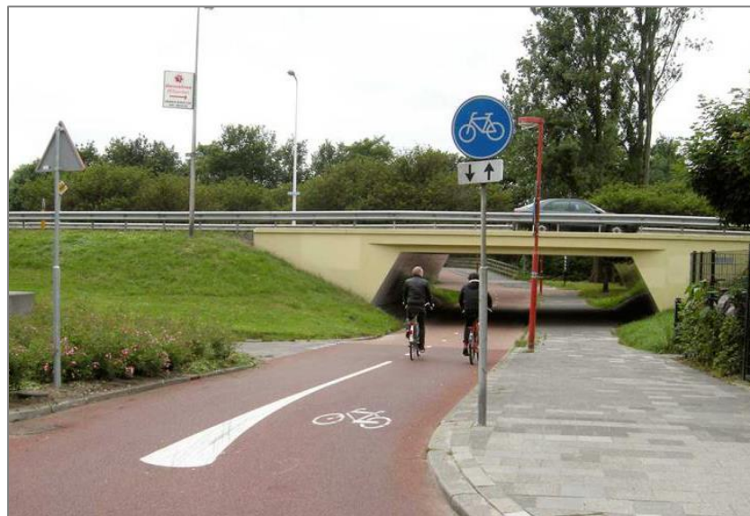
Bild 7-64 Großzügige Gestaltung einer Unterführung mit getrennten Geh- und Radwegen (Bild: Mark Treasure, Blog As Easy As Riding A Bike )
