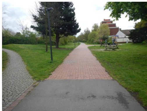
Bild 7-24 Nutzung der vorhandenen Trennung von Geh- und Radweg. Ausbau des Gehwegs empfohlen, um eine gute Akzeptanz durch den Fußverkehr zu erreichen. Im Fotobeispiel auch bituminöse Befestigung für Radweg (rechts) zu empfehlen.
