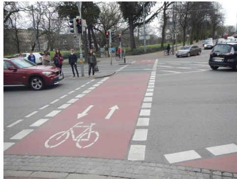
Bild 7-45 Am Wall/Herdentor: Abgesetzt liegende Zweirichtungsfurt im Zuge Am Wall
