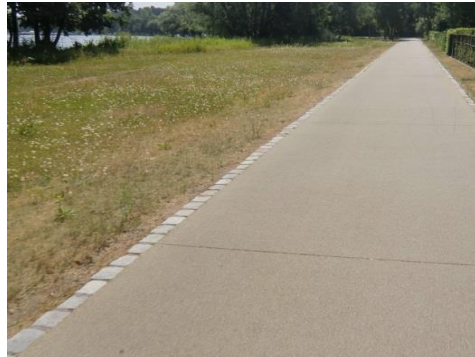
Bild 4-28 Aufgehellter bituminöser Belag in landschaftlich sensiblen Umfeld (Berlin)
