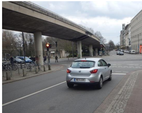
Bild 5-28 Am Wall, Bgm.-Smidt-Straße, Hochstraße
