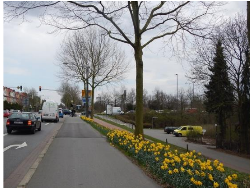
Bild 7-59 Geh- und Radweg Osterdeich in der Zufahrt zum Knotenpunkt Hastedter Brückenstraße
