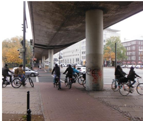
Bild 7-38 Am Wall/Bgm.-Smidt-Str.: Radverkehrsfurt über die Bgm.-Smidt-Straße mit langen Wartezeiten
