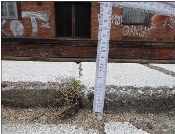
**Abbildung 7:** Am Bahnsteig in Bremen-Sebaldsbrück waren die Pflastersteine vor den Bahnsteigkanten stellenweise mehr als 4 cm abgesackt.
