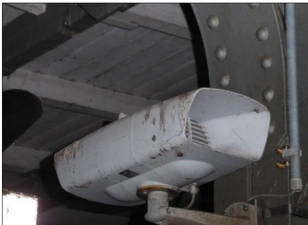
**Abbildung 47:** Lautsprecher unter dem Bahnsteigdach in Bremen-Vegesack waren mit Taubenkot verschmutzt.
