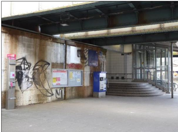
**Abbildung 40:** Der Zugang zum Bahnsteig in Bremen-Walle wird durch Schmierereien, Verschmutzungen und Ausblühungen im Mauerwerk beeinträchtigt.
