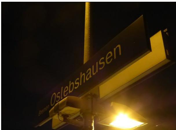
**Abbildung 21:** Keines der Bahnhofnamensschilder in Bremen-Oslebshausen war hinterleuchtet.
