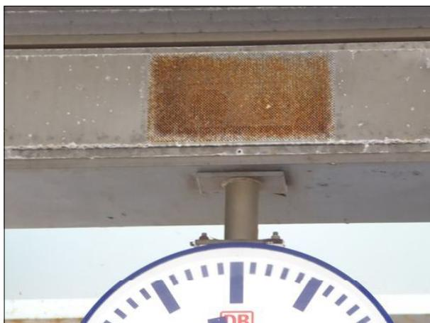
**Abbildung 18:** Die in die Dachträger integrierten Lautsprecheröffnungen in Bremerhaven-Lehe wiesen Korrosion auf.
