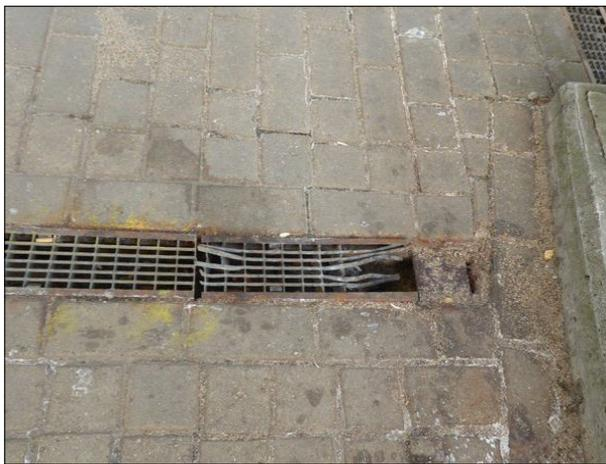
**Abbildung 8:** Die Entwässerungsrinne am südlichen Ende des Bahnsteigs in Bremen-Walle war beschädigt.
