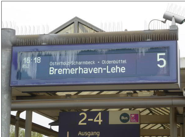
Abbildung 17: Der Zugzielanzeiger an Gleis 5 in Bremen-Burg war bereichsweise innen beschlagen.
