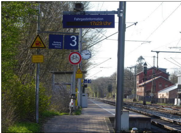
Abbildung 19: Die Uhr an Gleis 3 in Bremen-Oberneuland war defekt. Die korrekte Zeit wurde am Schriftanzeiger abgebildet.
