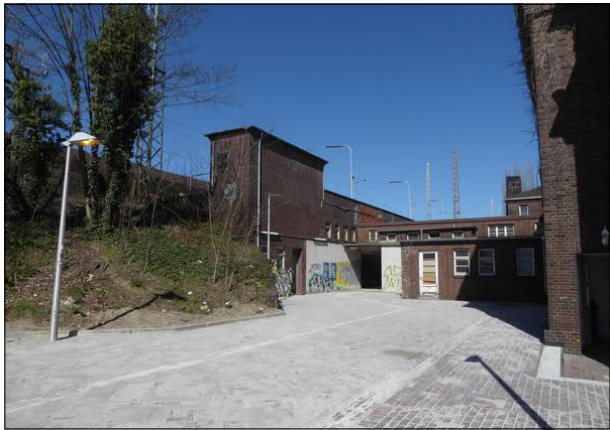
Abbildung 22: Der Zugang zum Bahnhof Bremen-Neustadt wurde neu gepflastert. Jedoch war der Eingang weder gekennzeichnet noch ausgeschildert.
