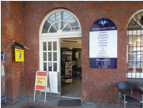
Abbildung 28: Im öffentlich zugänglichen Bereich des Bahnhofsgebäudes in Bremen-Vegesack haben der Kiosk mit Imbiss und das Reisezentrum gemeinsame Eingänge.
