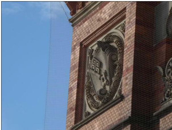
Abbildung 28: Die Fassade des Bremer Hauptbahnhofs wurde großflächig mit Netzen zur Taubenvergrämung abgespannt.
