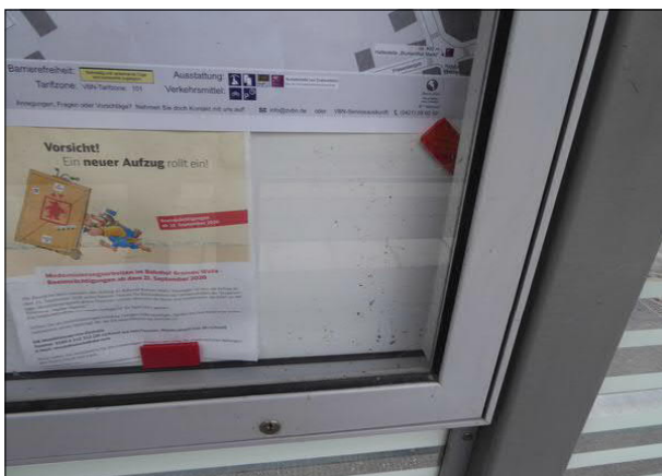
Abbildung 27: Die westliche Vitrine des Haltepunkts Bremen Mühlenstraße war verschmutzt. Außerdem hing noch eine seit gut drei Monaten veraltete Information zur Aufzugserneuerung in Bremen-Walle aus.
