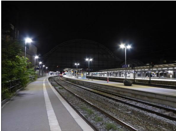
Abbildung 37: Die Bahnsteigbeleuchtung in Bremen Hbf wurde auf LED-Technik umgestellt. Das Ergebnis ist sehr gut.
