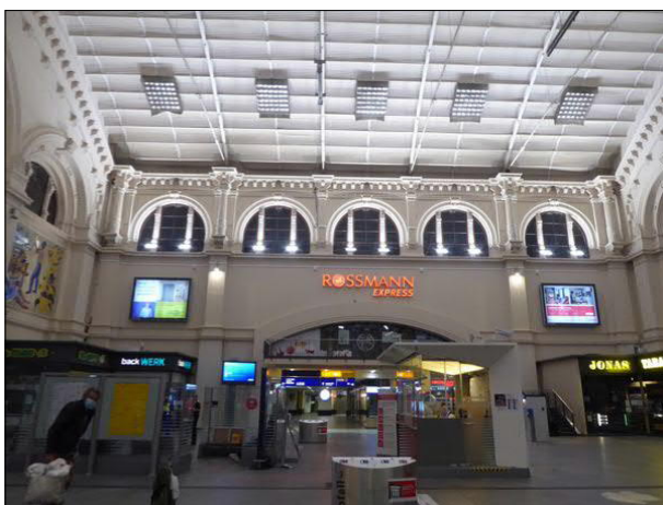
Abbildung 30: Die Empfangshalle des Hauptbahnhofs von Bremen wird über Reflektoren an der Decke indirekt beleuchtet.
