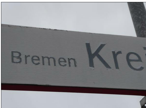
Abbildung 21: An einzelnen Schildern der Stationen im Bereich der FVE ist ein beginnendes Ablättern der Beschriftung zu beobachten. Das trifft auch auf dieses Bahnhofnamensschild in Bremen Kreinsloger zu.
