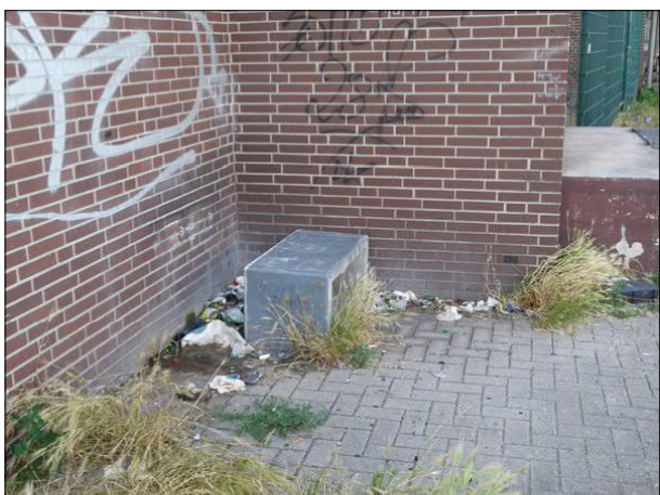
Abbildung 41: In Bremen-Burg ist der Bereich am südlichen Bahnsteigzugang vor dem Stellwerk durch Exkremente und Abfälle sehr unappetitlich.
