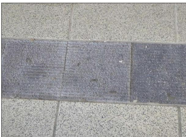
Abbildung 9: An den Gleisen 5 und 6 in Bremen Hbf haben sich die Rillen der Blindenleitstreifen in der Bahnsteighalle bereichsweise weitgehend aufgelöst.
