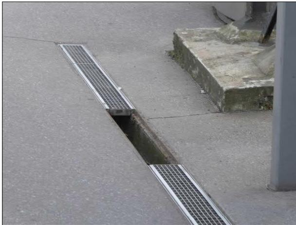
Abbildung 7: Auf zwei Bahnsteigen lagen in Bremen Hbf einzelne Gitterabdeckungen der Entwässerungsrinnen in den Rinnen. Durch die fehlenden Abdeckungen bestand Stolpergefahr.
