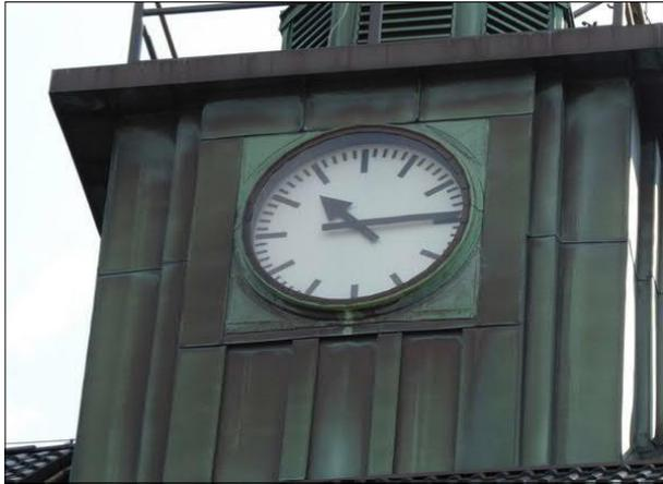
Abbildung 19: Der kleine Zeiger der Uhr im Turm des Bahnhofsgebäudes von Bremerhaven Hbf war etwas verdreht.
