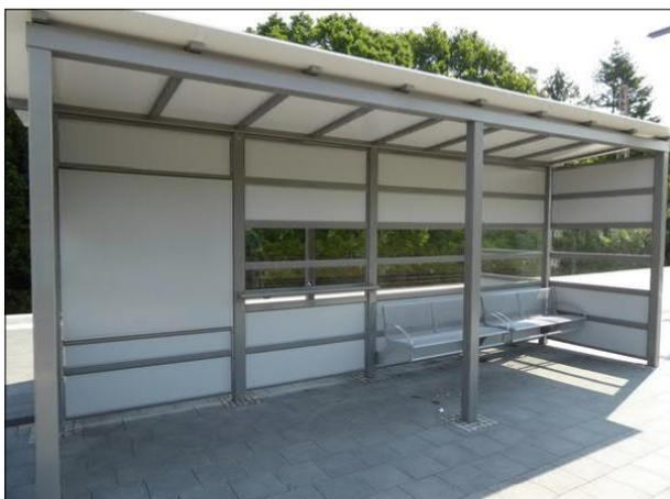
Abbildung 11: Die neuen Unterstände in Bremerhaven-Wulsdorf weisen eine eingeschränkte Transparenz auf. Es wurden nur zwei Reihen des Rasters verglast. Ungünstig ist auch die Anordnung einer Vitrinenrückseite im Unterstand.
