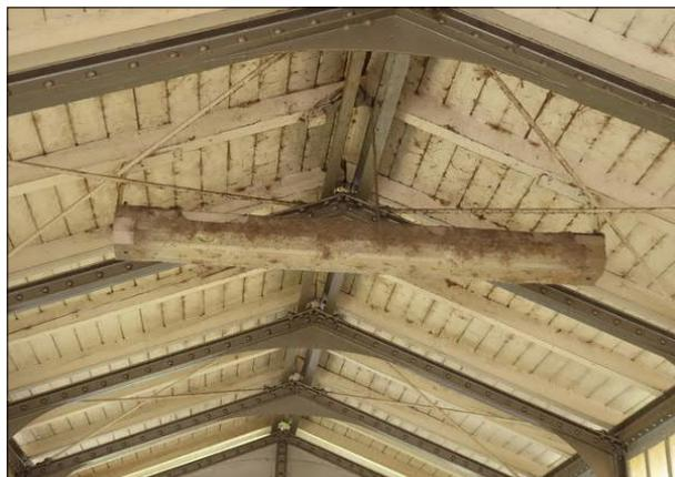
Abbildung 39: Die Leuchte in der Einhausung der Bahnsteigtreppe von Bremen-Sebaldsbrück war stark verschmutzt.
