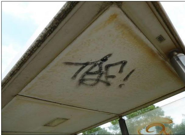
Abbildung 43: Die Dächer der Unterstände in Bremen-Burg waren einschließlich der Dachkanten überwiegend verschmutzt.
