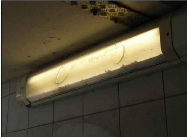
Abbildung 37: In Bremerhaven-Lehe waren alle Hauben der Leuchten im Tunnel und einzelnen Hauben der Dachleuchten auf dem Bahnsteig beschädigt.
