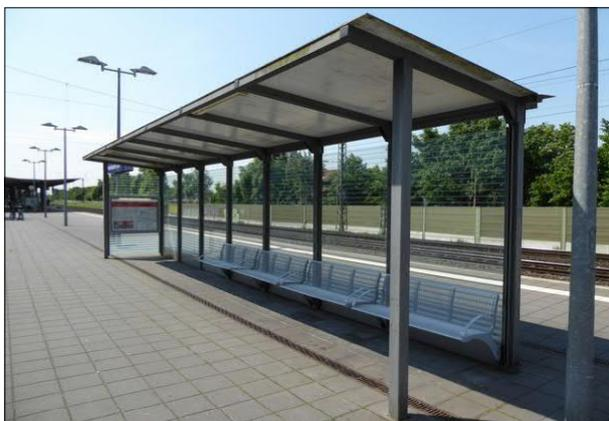
Abbildung 12: Eine Scheibe des Unterstands in Bremerhaven-Lehe fehlte, und es gab einzelne Verschmutzungen. Die Sitzbänke sind neu beschichtet worden, wodurch die im letzten Jahr verzeichneten Rostschäden beseitigt wurden.
