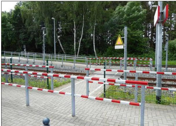
Abbildung 5: Die gleisquerenden Bahnsteigzugänge im Bereich der FVE sind alle ebenerdig angelegt. Sie sind mit Schallsignalen und Umlaufgittern gesichert. Hier ist der westliche Zugang des Bahnhofs Bremen-Aumund zu sehen.
