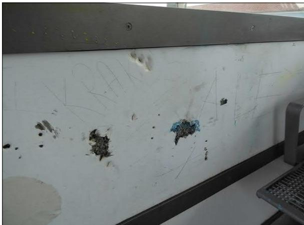
Abbildung 44: Diese Brüstung des Windschutzes unter dem Bahnsteigdach in Bremen-Oslebshausen ist seit mindestens acht Jahren beschädigt.
