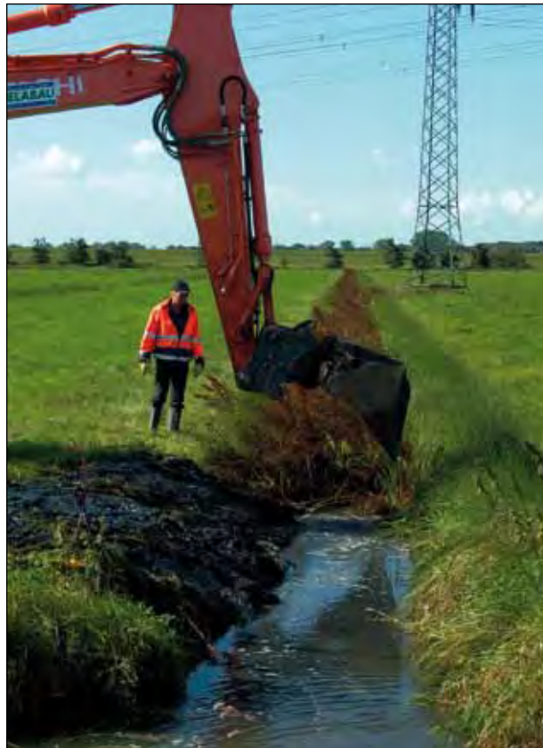
Wiederherstellung verlandeter Gräben durch schonende Räumung (hier im Niedervieland)
