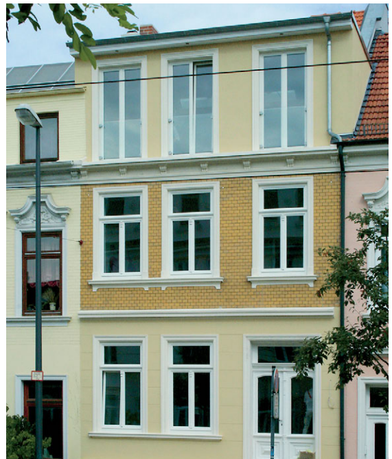
Modernisierte Außenfassade mit Innendämmung in Bremen-Peterswerder
