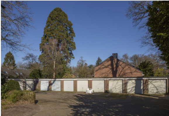
Abbildung 41: Garagenhof (Quelle: N. Wolff, Fotoetage)
