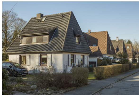
Abbildung 10: Reihe der Einfamilienhäuser (Quelle: N. Wolff, Fotoetage)
