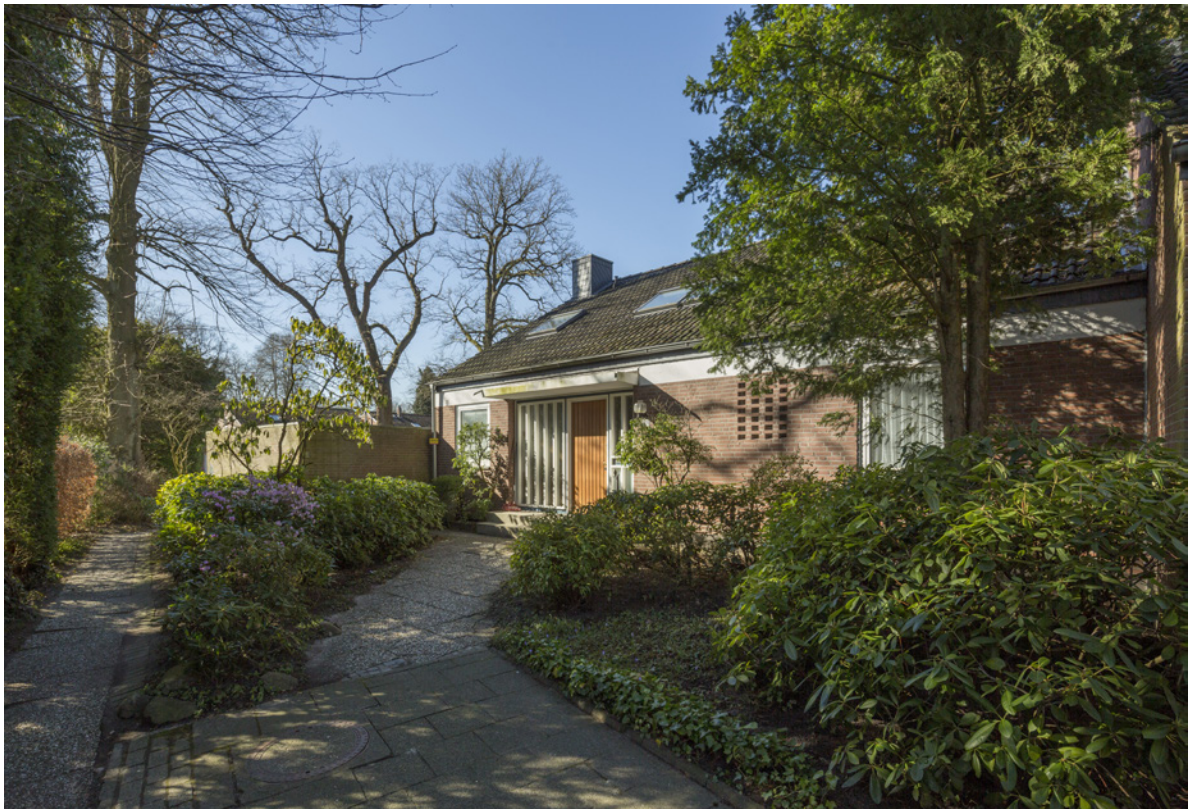
Abbildung 26: Wohnweg mit fußläufiger Erschließung (Quelle: N. Wolff, Fotoetage)
