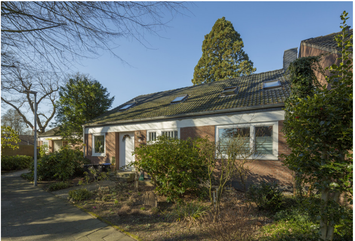
Abbildung 37: Reihenhauses Ansicht mit Putzband (Quelle: N. Wolff, Fotoetage)
