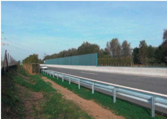
Neben den Überführungsbauwerken im Bereich der Anschlussstellen wurde in diesem Bauabschnitt eine Überflughilfe für Fledermäuse realisiert – hierdurch sollen Kollisionen zwischen Fledermäusen und dem Kfz-Verkehr minimiert werden.
