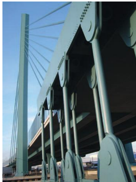
Zugverankerung der Schrägseile
