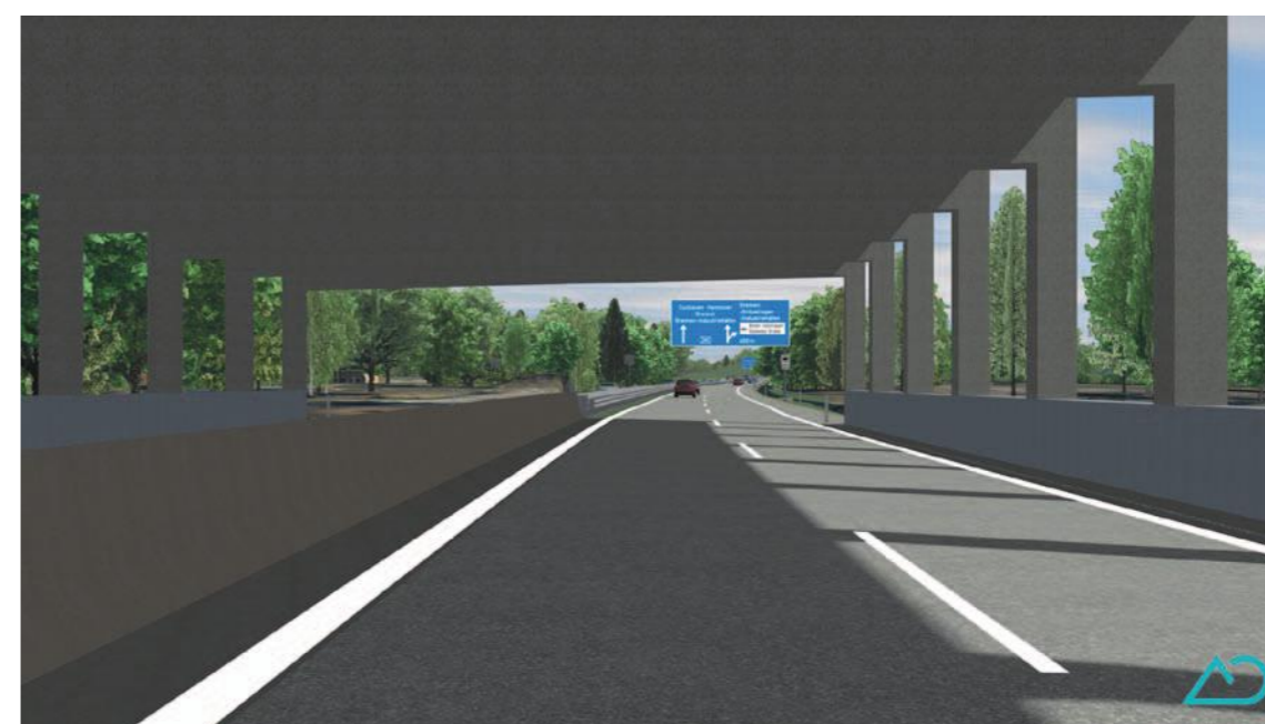
Tunnelausfahrt mit Einhausung, Blick Richtung Gröpelingen
