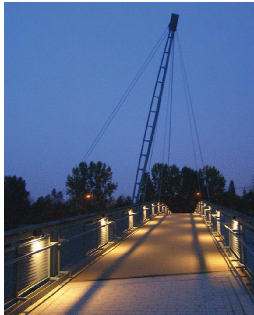
Bauabschnitt 3/1: Fußgängerbrücke im Zuge der Visbeker Straße
