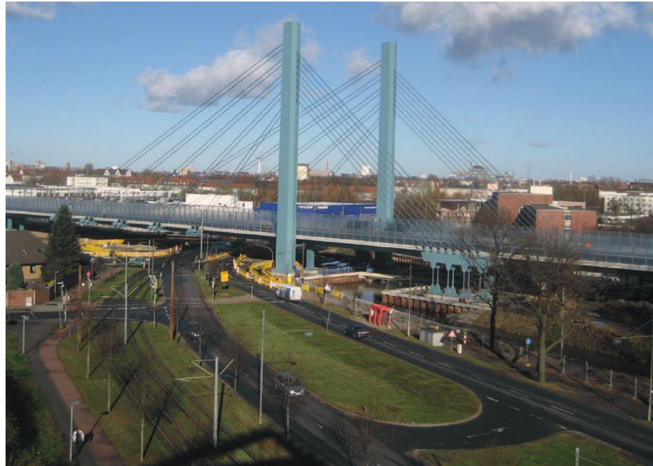
Bauabschnitt 2/1: Schrägseilbrücke über den Flughafendamm
