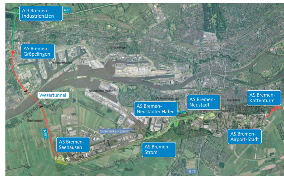
Autobahn-Eckverbindung 281: bisher gebaute Bauabschnitte 2/1, 3/1 und 3/2
