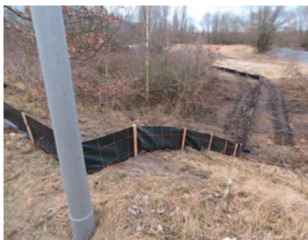
Vor Baubeginn aufgestellter Amphibienschutzzaun
