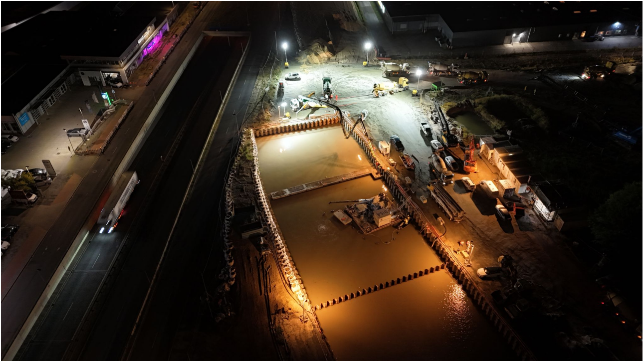
A 281 BA 2/2: Herstellung des Trogbauwerkes im Bereich des Knotenpunktes Neuenlander Straße / Kattenturmer Heerstraße. [Stand September 2025, Bildrechte © Implenia]
