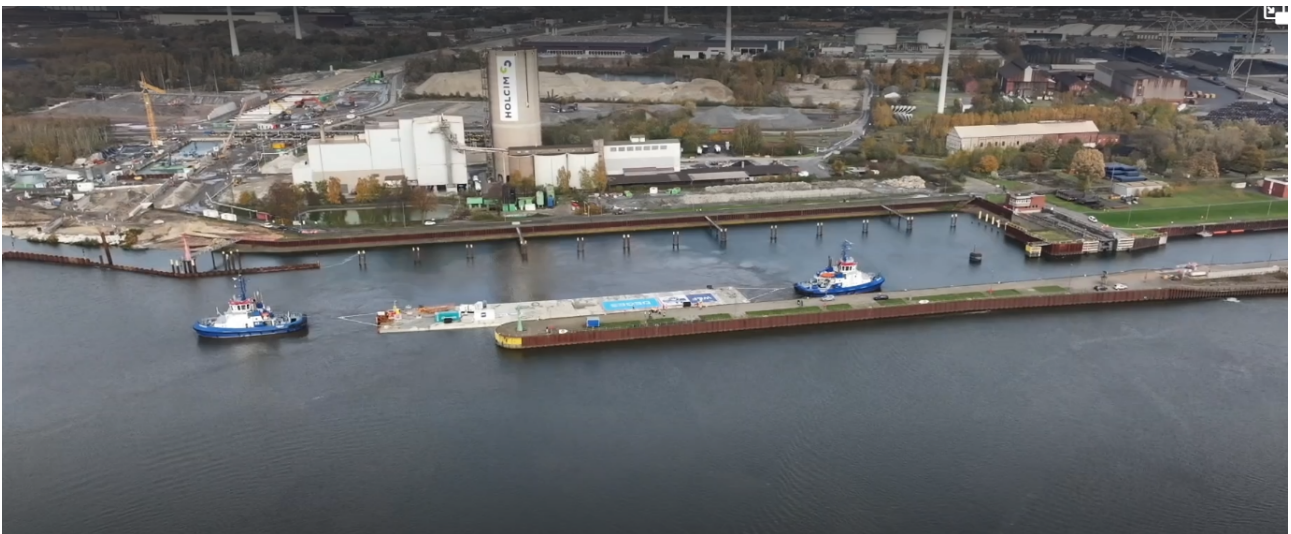
A 281 BA 4: Ankunft des ersten Tunnelelementes [November 2025, Bildrechte buten un binnen]
