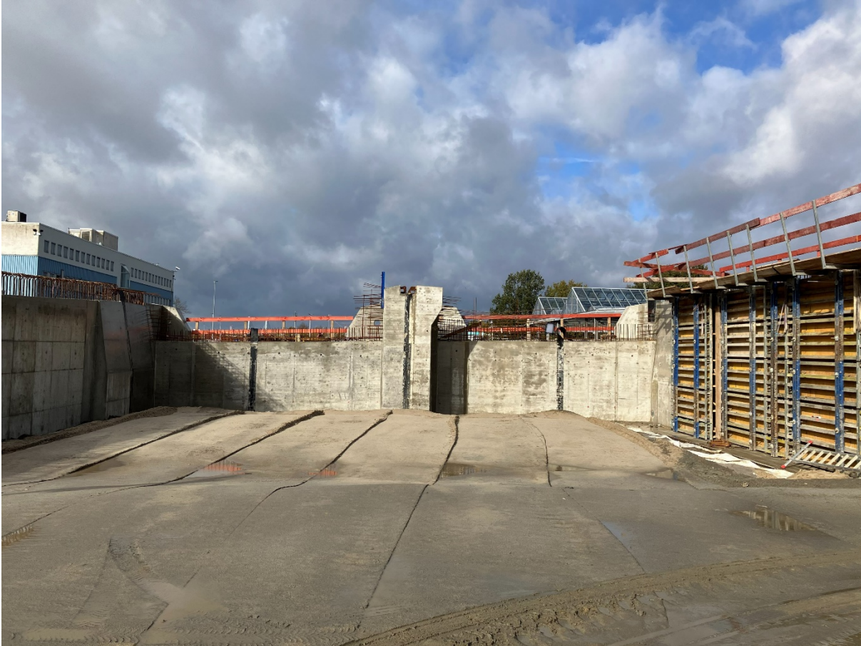
A 281 BA 2/2: Herstellung Widerlager zur Verlängerung der Hochstraße [Stand November 2025]
