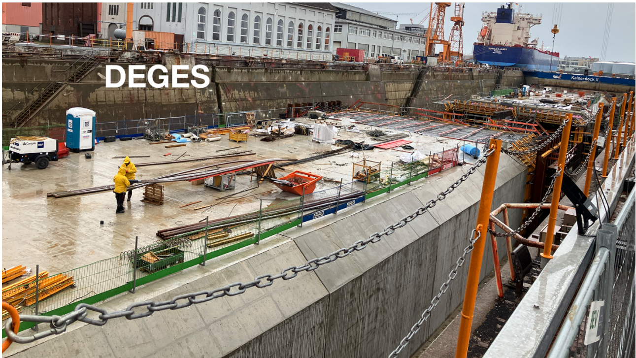
A 281 BA 4: Herstellung der Tunnelelemente in Bremerhaven [September 2025]
