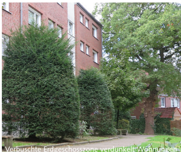
Verbuschte Erdgeschosszone verdunkelt Wohnungen
