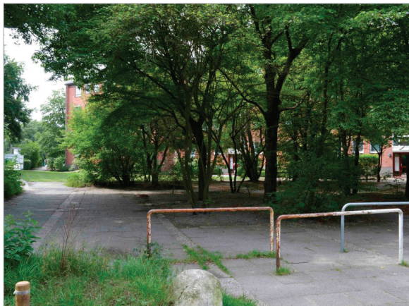
Abb. 6 Überarbeitungsbedürftiger Eingangsbereich des Karl-Heinz-Jantzen-Weges
