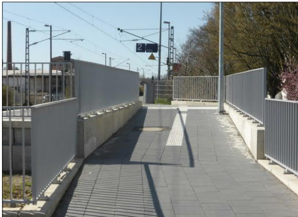
Abbildung 5: Auf der im Zusammenhang mit der Bahnsteigverlängerung neu errichteten Rampe zu Gleis 2 in Bremen-Schönebeck wurde das Blindenleitsystem mit dem auf der Rampe beginnenden taktilem Leitstreifen nicht regelkonform angelegt.
