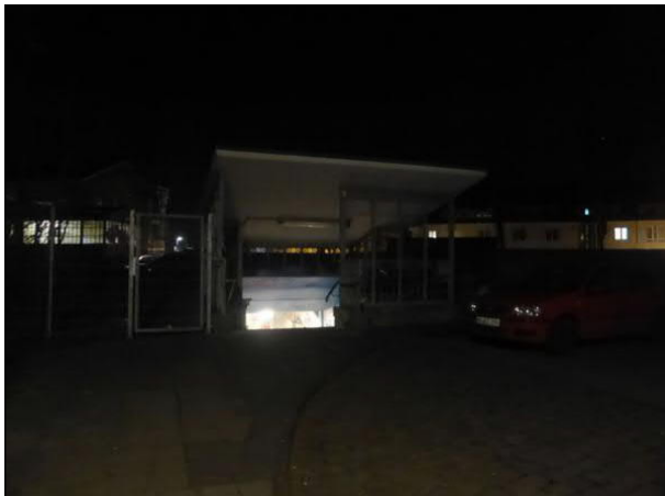
Abbildung 37: Die Beleuchtung am nördlichen Treppenzugang der Unterführung zum Bahnsteig in Bremen-Sebaldsbrück war defekt. Der Bereich auf dem Vorplatz ist ohnehin nur schwach beleuchtet.
