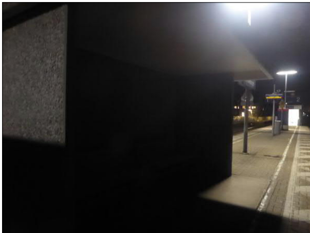
Abbildung 11: Die Unterstände auf dem Bahnsteig in Bremen-Hemelingen sind alle unbeleuchtet. Durch die Betonbauweise der Wände und Dächer dringt bei Dunkelheit kein Licht der Bahnsteigbeleuchtung hinein.
