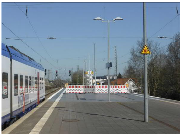
Abbildung 3: In Bremerhaven-Lehe waren die vor mehr als einem Jahr begonnenen Arbeiten zur Bahnsteigverlängerung für der Einsatz längerer Züge noch immer nicht abgeschlossen.
