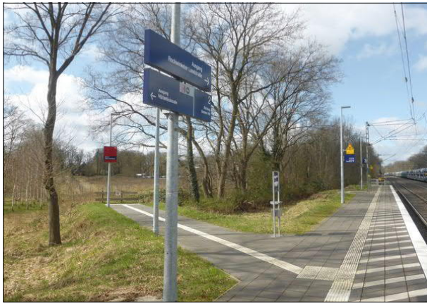
Abbildung 22: Der bereits vor vier Jahren bei der Bahnsteigerneuerung an dieser Stelle in Bremen-Oberneuland in das Wegeleitsystem aufgenommene Zugang am westlichen Ende von Gleis 3 wurde immer noch nicht hergestellt.
