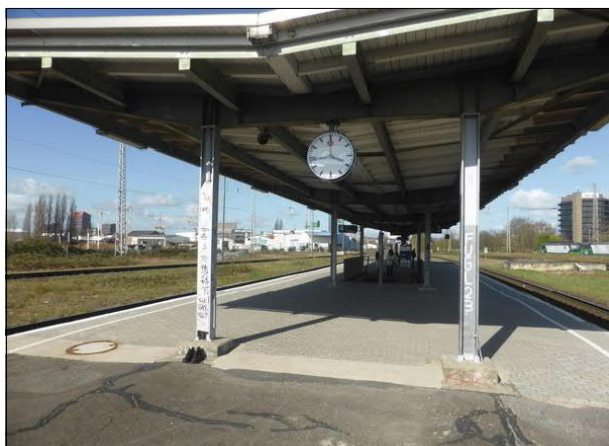
Abbildung 2: Der Bahnsteig in Bremen-Neustadt wurde unter dem Bahnsteigdach mit einer Neupflasterung etwas aufgehöhht.
