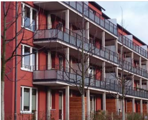
neue Fassade mit Vorstellbalkonen
