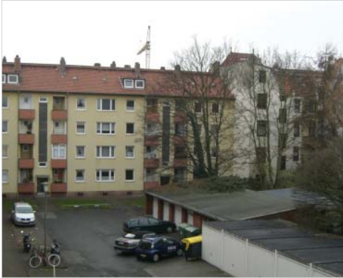
Innenhof vor der Modernisierung
