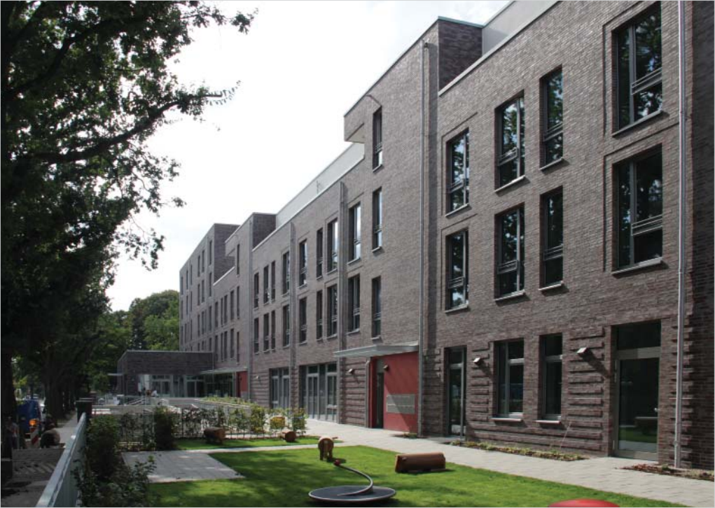
Ansicht Eingänge Niedersachsendamm
