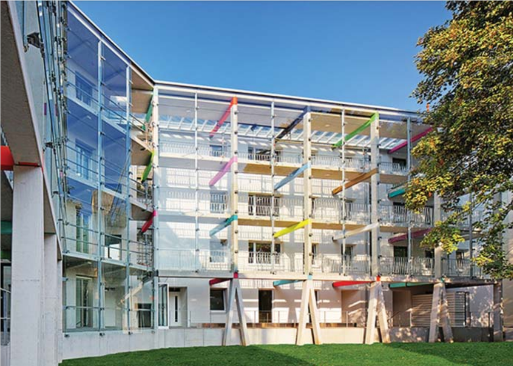
Innenhof neue Fassade mit Laubengang
