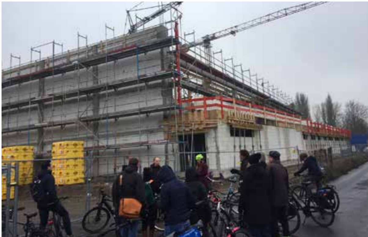
Besuch der Baustelle des Campus Ohlenhof 2020
