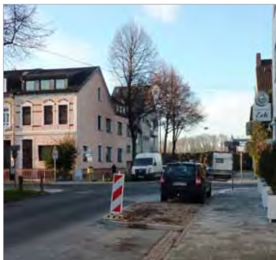
Nach dem Umbau - Baumpflanzung erfolgt noch
