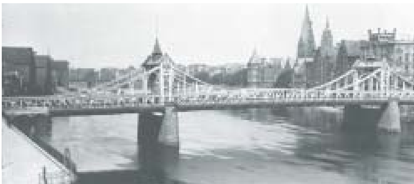
Die Große Weserbrücke 1899
