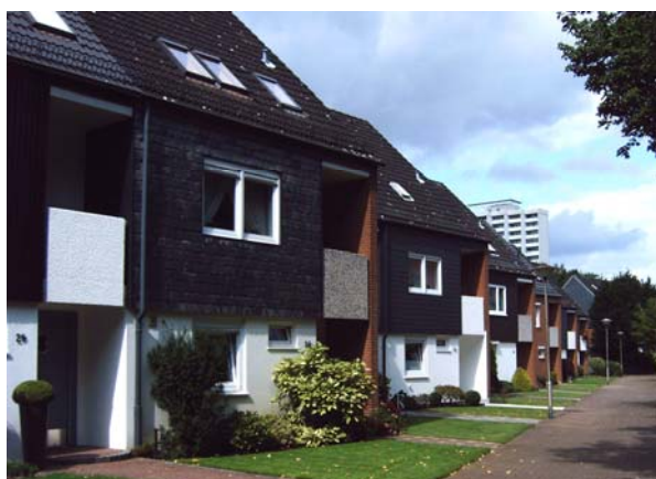
Foto 18: Reihenhausbebauung im Hahnenkampquartier
