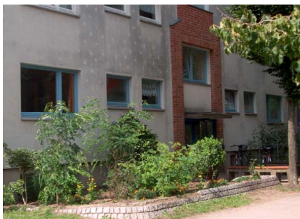
Foto 17: Geschoßwohnungsbau in der Zermatter Straße
