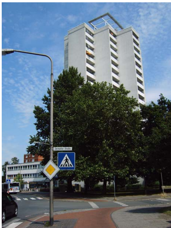
Foto 16: Hochhaus St. Gotthard Str. 31
