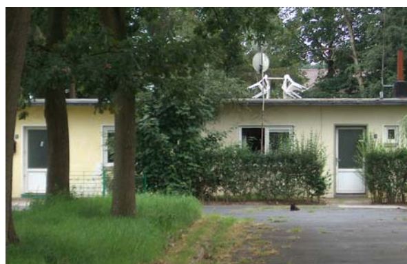
Foto 6: Schlichtbauten an der Großen Lake
