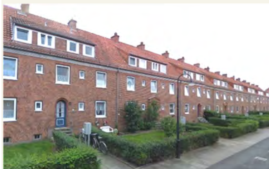
Abbildung 17 Denkmalgeschützte Siedlung Auf dem Beginenlande
