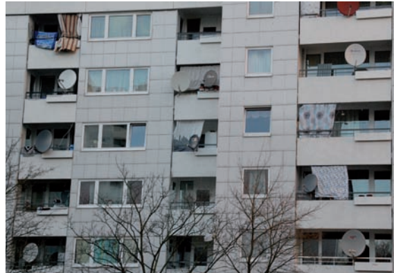
Ansicht einer Fassade der Grohner Düne mit Balkonen
