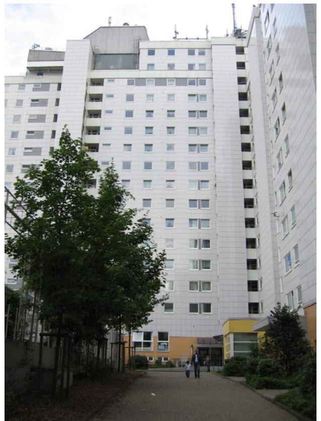
Foto 1: Ringförmiges Hochhaus im Schwerpunktgebiet.
