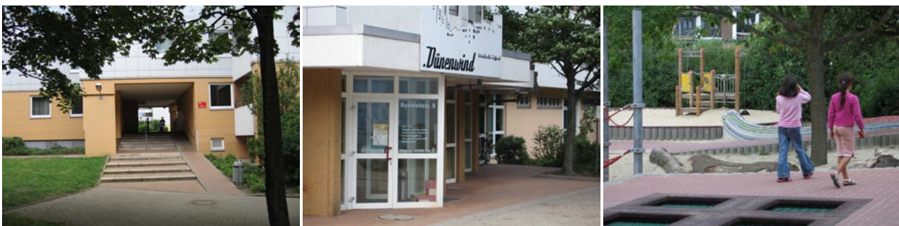
Foto 3, 4 und 5: Ein Eingang in den Innenbereich des ringförmigen Hochhauses; Bewohnertreff „Dünenwind“; Kinderspielplatz im Schwerpunktgebiet.
