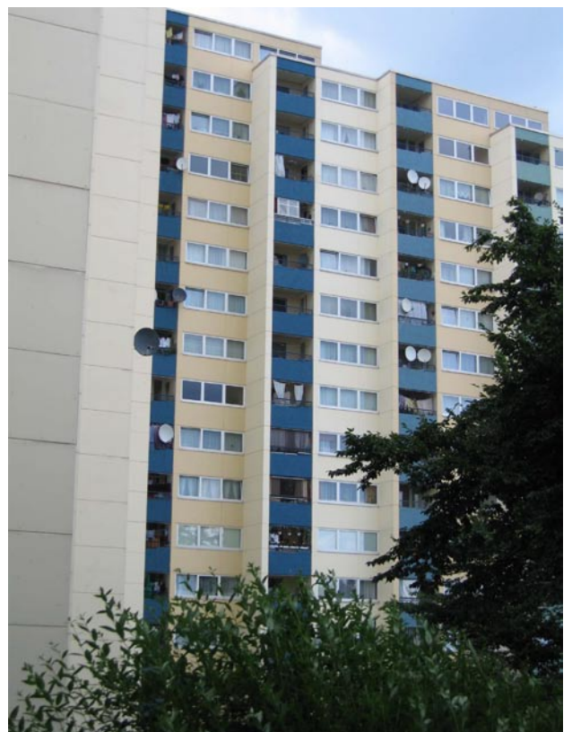
Foto 2: L-förmiges Hochhaus im Schwerpunktgebiet.
