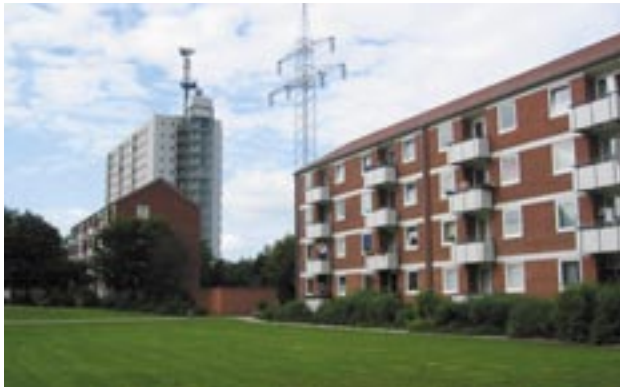
Foto 1: Wohngebäude im Schwerpunktgebiet
