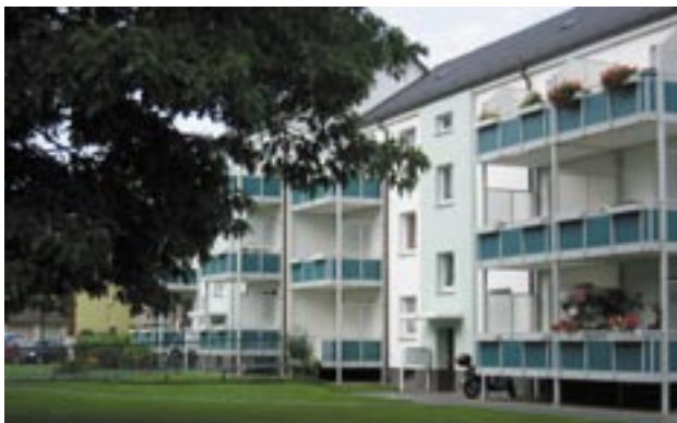
Foto 3: Wohngebäude mit Balkonanbauten im Schwerpunktgebiet
