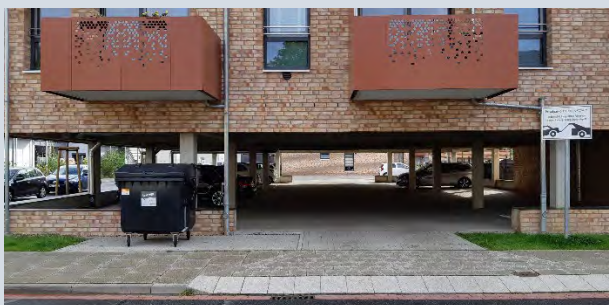
Abb. 37 Integration eines Parkplatzes in das Erdgeschoss in Bremen-Nord, Foto: BPW Stadtplanung
