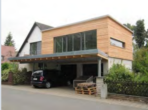
Abb. 45 Garagenaufstockung in Schwabach, Quelle/Fotos: https://kleinoeder.de/garage-aufstockung-in-schwabach/
