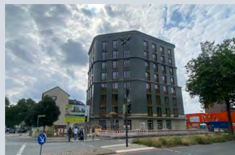
Abb. 38 Ersatz eines Parkplatzes mit ca. 20 Stellplätzen durch 52 geförderte Wohnungen, Foto: BPW Stadtplanung
