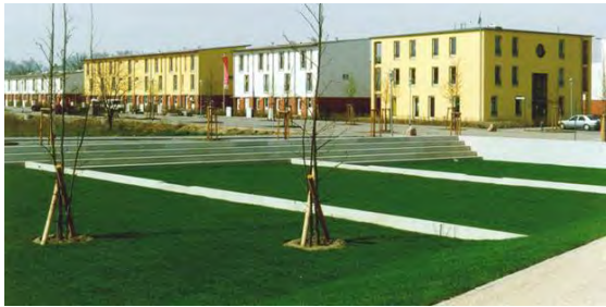
Abb. 138 Regenrückhaltebecken in Potsdam als Quartiersplatz mit einer maximalen Stauhöhe von 30 cm, Quelle: bgmr Landschaftsarchitekten
