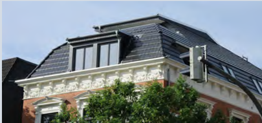
Abb. 113 Ausbau eines Daches für zwei neue Wohneinheiten, Architekt unbekannt, Foto: Henning Höpken, Quelle: https://dachdirekt.de/artikel/dachausbau-innenausbau-bremer-buergerhaus
