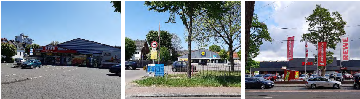
Abb. 49 eingeschossige Einzelhandelsbetriebe mit Parkplätzen, Fotos: BPW Stadtplanung
