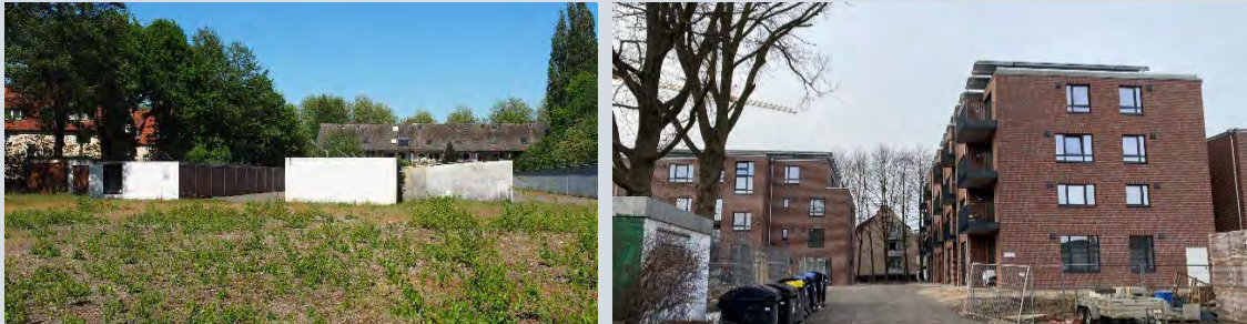
Abb. 30 Überbauung eines ehemaligen Garagenhofs in der Seewenjestraße (89 Garagen, 72 für PKW genutzt), ca. 70 WE + Räume für WaBeQ und Lebenshilfe, Vorhabenträgerin: Waller Beschäftigungs- und Qualifizierungsgesellschaft mbH (WaBeQ), Sieber Architekten BDA Bremen, Fotos: BPW Stadtplanung
