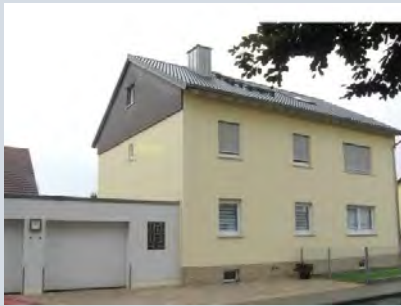
Abb. 46 Wohnhauserweiterung (eine zusätzl. WE) durch Garagenaufstockung in Holzrahmen-Bauweise Architekt: Martin Gottwald (Roßdorf) Quelle/Fotos: https://www.gottwald-architekt.de/projekte/umbau-erweiterungen/
