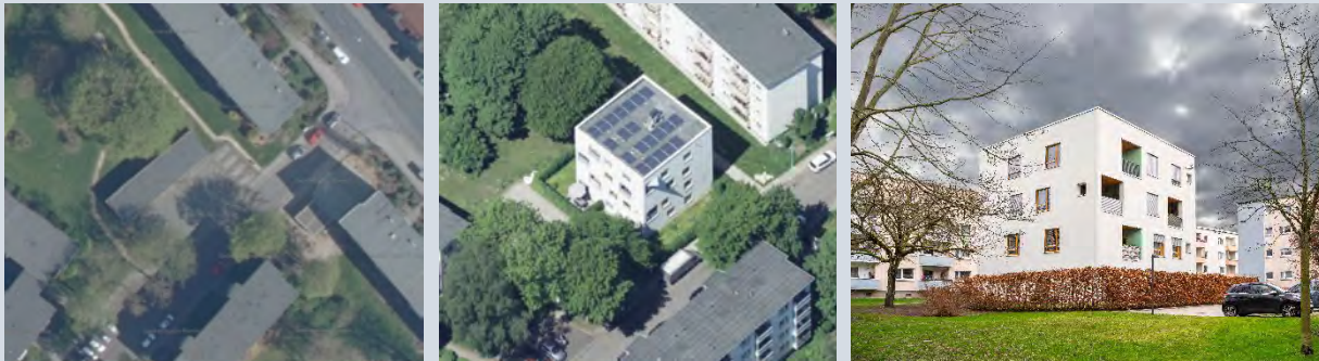
Abb. 119 und Abb. 120 Bremer Punkt in der Gartenstadt Süd, acht geförderte Wohneinheiten, LIN Architekten Urbanisten; Quelle/Fotos: GeoInformation / BPW Stadtplanung
