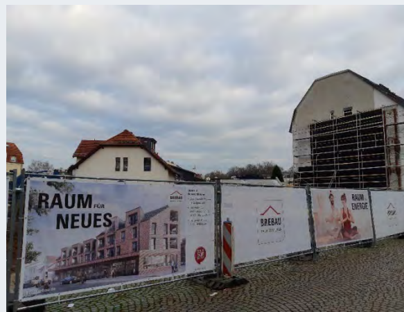
Friedhofstraße, Schwachhausen, Brebau (im Bau, Stand 05/2022): 26 WE auf der Fläche eines ehemaligen Supermarktes
