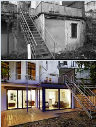
Abb. 111 Souterrainausbau zur Schaffung einer neuen Wohneinheit, Architekt Dennis Winkler, Quelle: www.dewink.de , Foto: Christian Burmester
