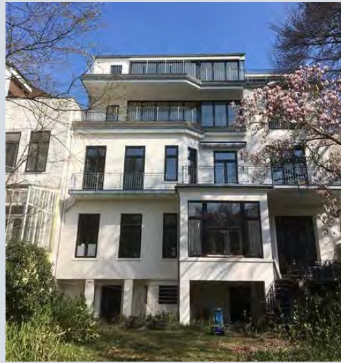
Abb. 106 Dachaufstockung zur Schaffung von vermutlich zwei neuen Wohneinheiten, Püffelarchitekten BDA, Quelle/Foto: Frank Püffel, Architekt http://www.pueffelarchitekten.de
