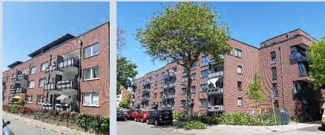
Abb. 118 Zahl der neuen Wohnungen unbekannt, Entwicklung durch die ESPABAU, Foto: BPW Stadtplanung
