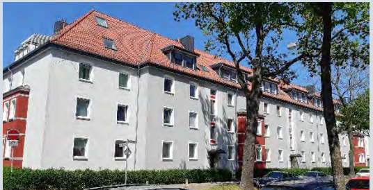
Abb. 117 Dachgeschossausbau für 38 neue Wohnungen durch die ESPABAU, Planungsgemeinschaft Nord GmbH, Foto: BPW Stadtplanung
