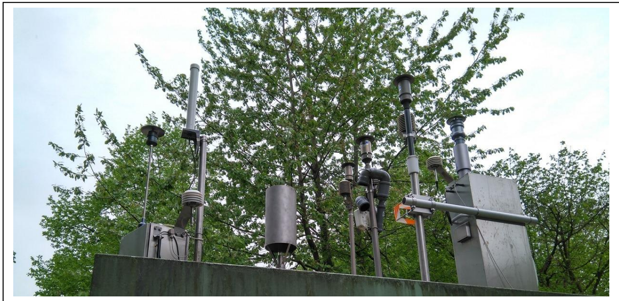
Foto: Parallelversuch in Bremen Ost, Dachprobenahmen
