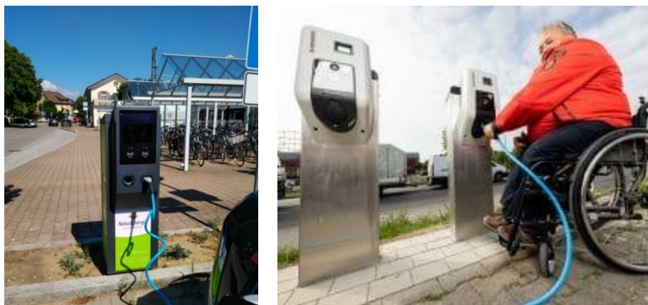
Abbildung 17: Barrierefreie Ladesäulen in Steinen (links) und Münster (rechts) 38
