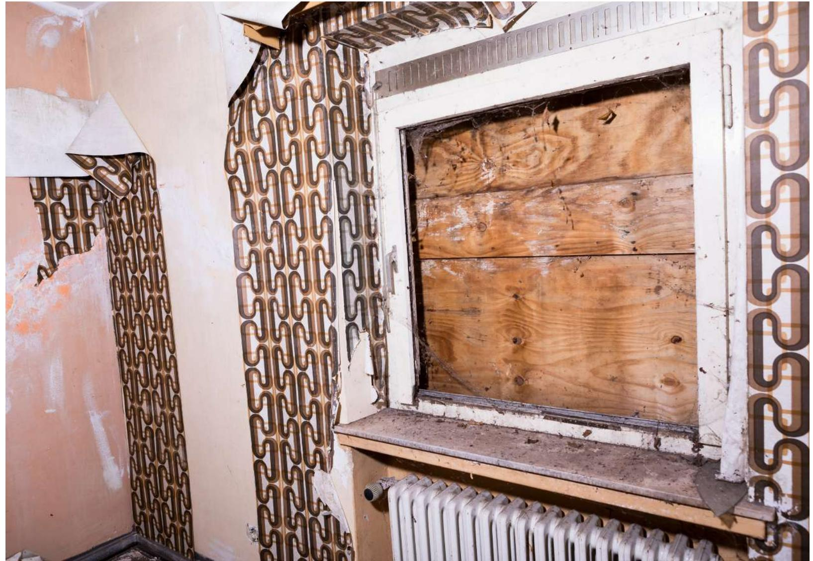
Feuchtigkeitsschäden sind zum großen Teil durch Nässe, die durch die Fenster oder andere Einbruchstellen in den Innenraum gelangt ist, entstanden.
