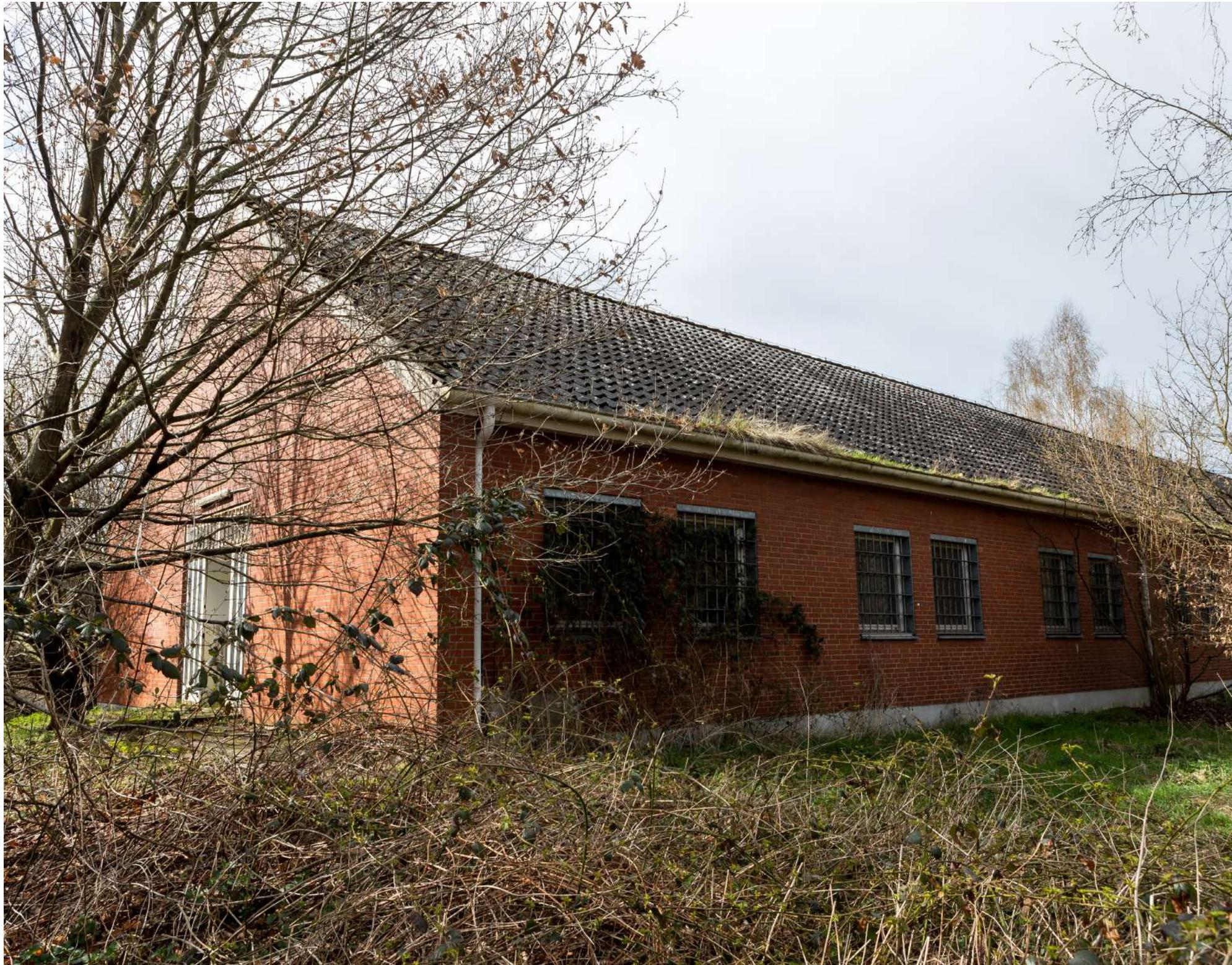
Aufgrund des Moorbodens und der hohen Grundwasserstände wurden die Gebäude auf einer tiefen Schicht aus Füllsand gegründet, weshalb sie etwas höher als das Gelände liegen.
