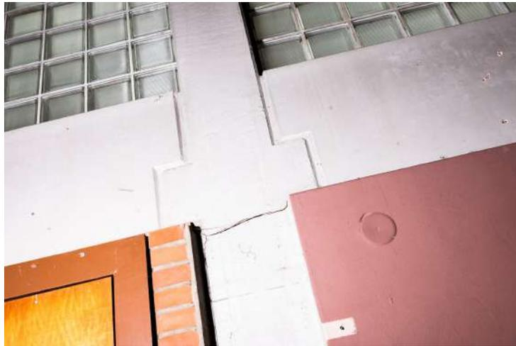
Sowohl die Mehrzweckhalle, als auch die Turnhalle, sind zwar mit einer Grundkonstruktion aus Stahlbeton ausgestattet, allerdings sind die nicht-tragenden Bauteile durch den fehlenden Betrieb von Lüftung und Heizung in einem baufälligen Zustand.
