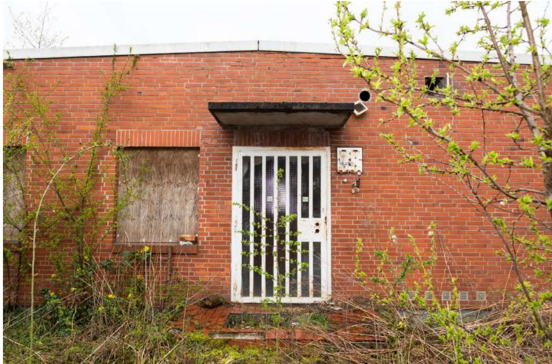
Alle Gebäude verfügen grundsätzlich über einen ebenerdigen Zugang, der sich im Moment allerdings trotzdem als Schwelle darstellt, da das umliegende Erdreich teilweise stark abgesunken ist.
